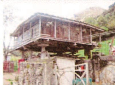
Lámina 4.- Vista general de la panera.
