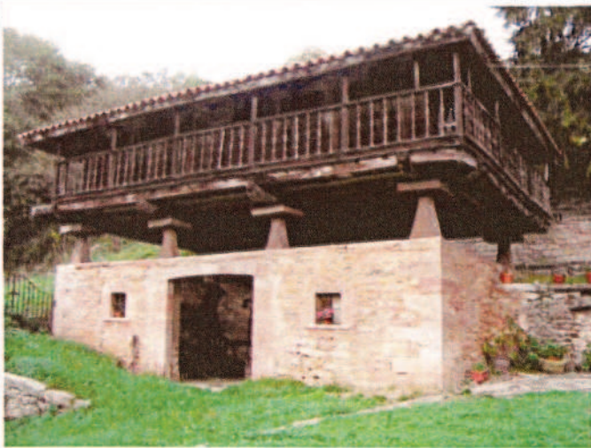
Lámina 1.- Vista general de la panera
