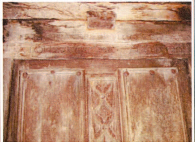
Lámina 2.- Inscripción y puerta de la fachada sur.
