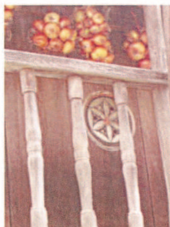
Lámina 3.- Balaustres torneados y roseta en el lateral sur.
