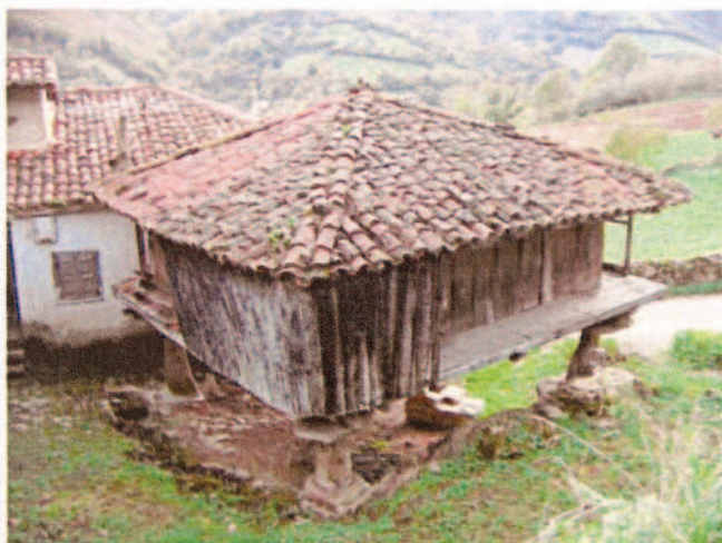
Lámina 1.- El hórreo con su tornaaguas en la esquina.
